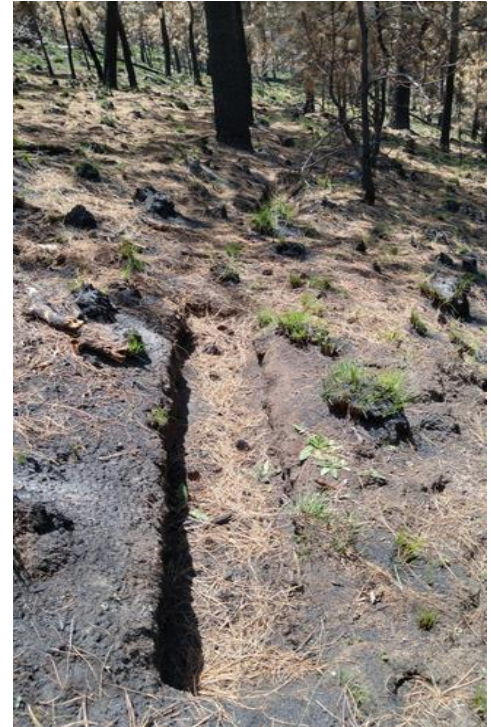
Imagen 14. Zanjas filtradoras de agua.
