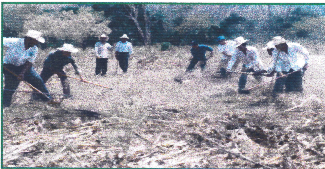
Fotografía No. 53 Construcción de la línea de control.
