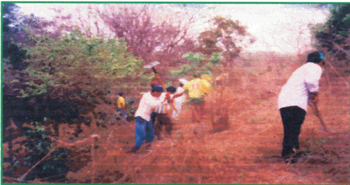
Fotografía No. 20 Construcción de la línea de control
