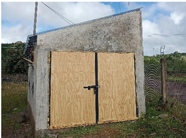
**Imagen 1.** Secadora solar para madera de pino. Grupo de mujeres "Artesanas en Madera de la Sierra Norte de Puebla S.P.R. de R.L."
