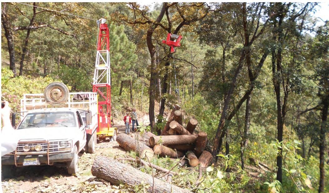
Imagen 22. Extracción de madera en rollo con cable aéreo, Mascota, Jalisco.
