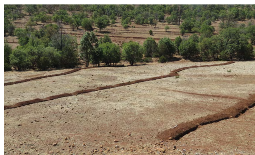
Imagen 61. Ejido Chineachi, municipio de Carichi, Chih. Obra de restauración de suelo: zanja bordo en curvas a nivel.
