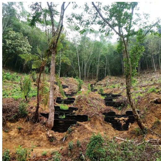
Imagen 70. Presa de Geocostal. Tlanextla, Atzingo Veracruz. CONAFOR. 2021.
