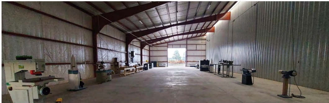
Imagen 132. Nave industrial de la línea de producción de muebles del Ejido El Largo y Anexos.
