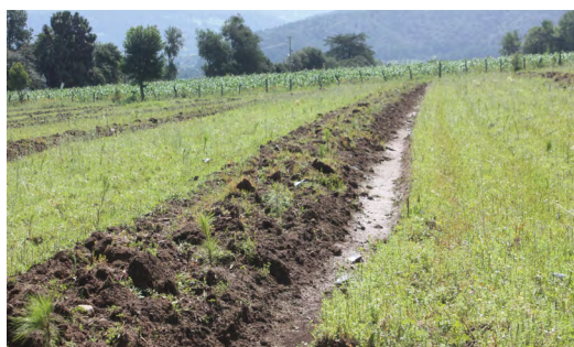
Imagen 60. Ejido Laguna Verde, municipio de Ocampo, Mich. Obra de restauración de suelo: bordos en curvas a nivel y reforestación.
